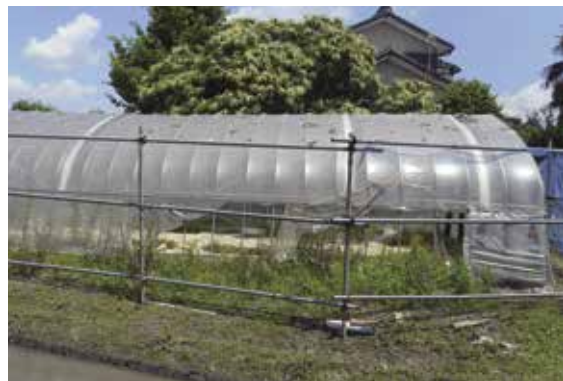
▲ひょうと突風で損壊したハウス (春日部市)
