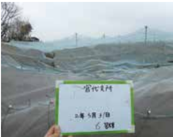
雪の重さで支柱が折れ曲がり損壊した多目的ネットハウス
